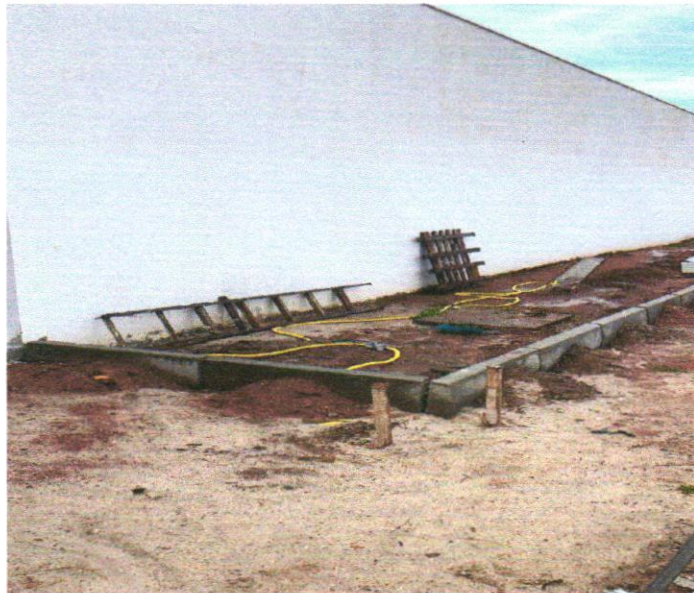
FOTO 229: GUIA DE MEIO FIO
